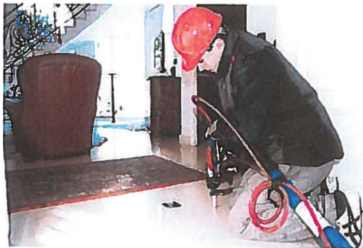
FOTO nº7: Intervención en una vivienda habitada
